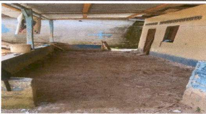
Foto 3: retirando piso anterior en el corredor del aula 1.
