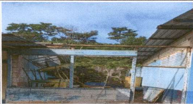
Foto 1: Cambiando techo de la cocina y toda la estructura.
