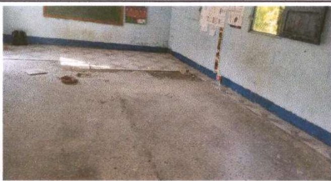
Foto 3: colocando piso cerámico para las aulas
