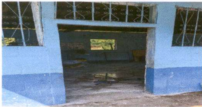
Foto 1: cambiando puertas que estaban en mal estado
